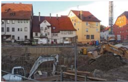
Aushubarbeiten im Oktober 2013
