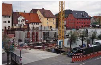
Das Fundament steht – November 2013
