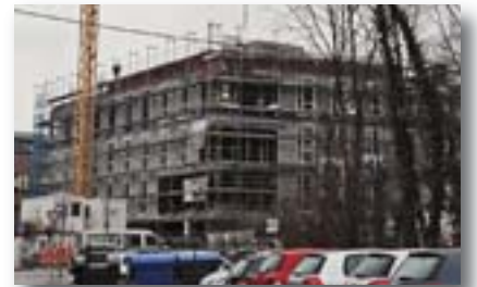
Rohbau kurz vor Fertigstellung – Januar 2014
